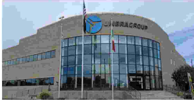
Nuovo centro riparazioni La struttura realizzata a Saginaw, in Michigan
